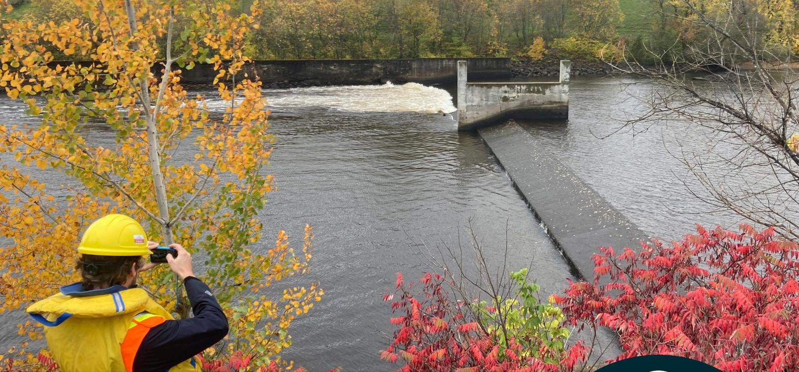
Le débit de la rivière a été réduit durant quelques jours à la fin septembre pour faciliter l'inspection de la structure en béton, habituellement recouverte d'eau. Avisés bien à l'avance, certains riverains en ont même profité pour réaliser des travaux sur leur quai!
